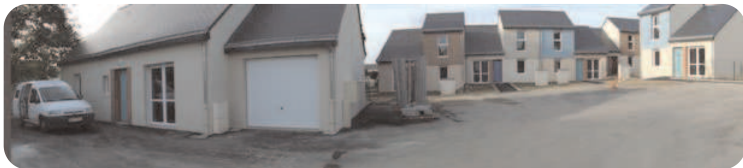
Logements nouvellement réalisés à l'impasse du Cloître
